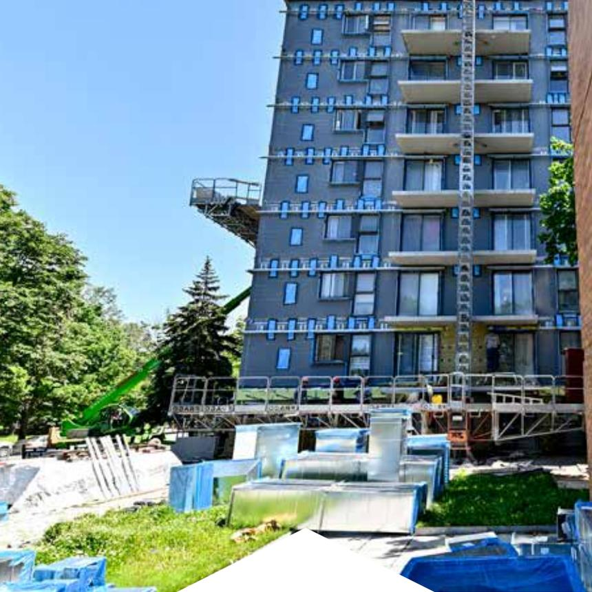
Les travaux majeurs aux habitations André-Grasset consistent, entre autres, à remplacer la brique, les portes et les fenêtres et à installer une toiture blanche.
