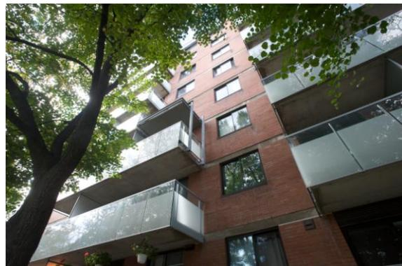
Tous les 5 ans, l'Office doit inspecter tous ses bâtiments de 5 étages et plus. C'est une obligation légale pour les propriétaires. À la suite de l'inspection des façades, l'Office doit apporter quelques correctifs. Des travaux doivent donc être réalisés pour éviter une dégradation plus importante de la maçonnerie et du revêtement des balcons. Ils rendront votre immeuble plus étanche pour qu'il reste en bon état longtemps.
