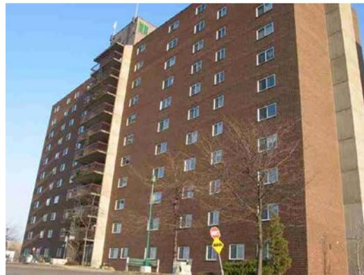
Tous les 5 ans, l'Office doit inspecter tous ses bâtiments de 5 étages et plus. C'est une obligation légale pour les propriétaires. L'inspection des façades de votre immeuble a révélé quelques anomalies. L'Office doit donc apporter les correctifs nécessaires. Ces travaux permettront d'éviter une dégradation plus importante de la maçonnerie et du revêtement des balcons. Ils rendront votre immeuble plus étanche pour qu'il reste en bon état longtemps.
