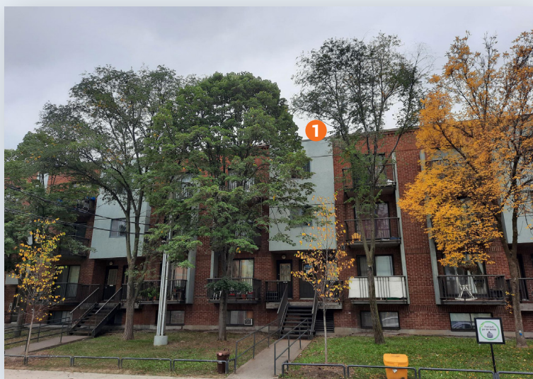
1 Remplacement de la toiture.
