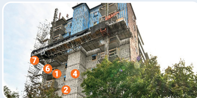
Façade donnant sur la rue Lajeunesse
