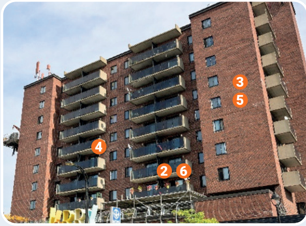
Façade donnant sur la rue Jarry
