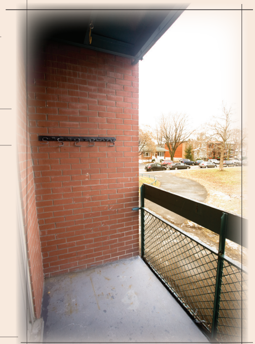
BALCON DÉGAGÉ, PRÊT POUR LES TRAVAUX.
