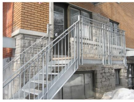
Les garde-corps des balcons et des escaliers sont maintenant en acier galvanisé qui offre plus de résistance aux intempéries et facilite l'entretien.
