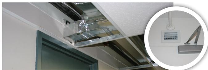
▲ De l'air neuf sera amené par le conduit dans le plafond du corridor et pourra entrer dans chaque logement par la grille installée au-dessus de la porte d'entrée.
