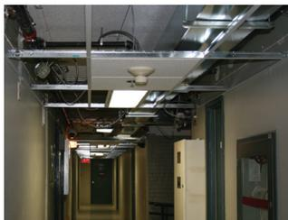
▲ Le plafond suspendu a dû être descendu de quelques centimètres pour permettre à la gaine de passer et d'apporter l'air dans chaque logement. L'installation de la gaine a aussi nécessité la relocalisation des détecteurs de chaleur, des détecteurs de fumée et des gicleurs.
