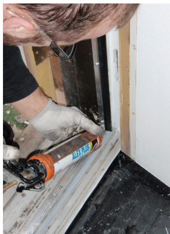
Un ouvrier travaille à la remise en état d'une fenêtre.
